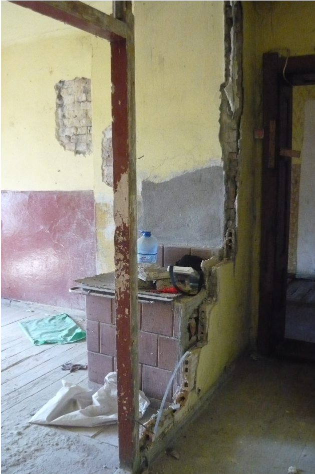
Foto. 19. Brak wypełnienia ściany.
