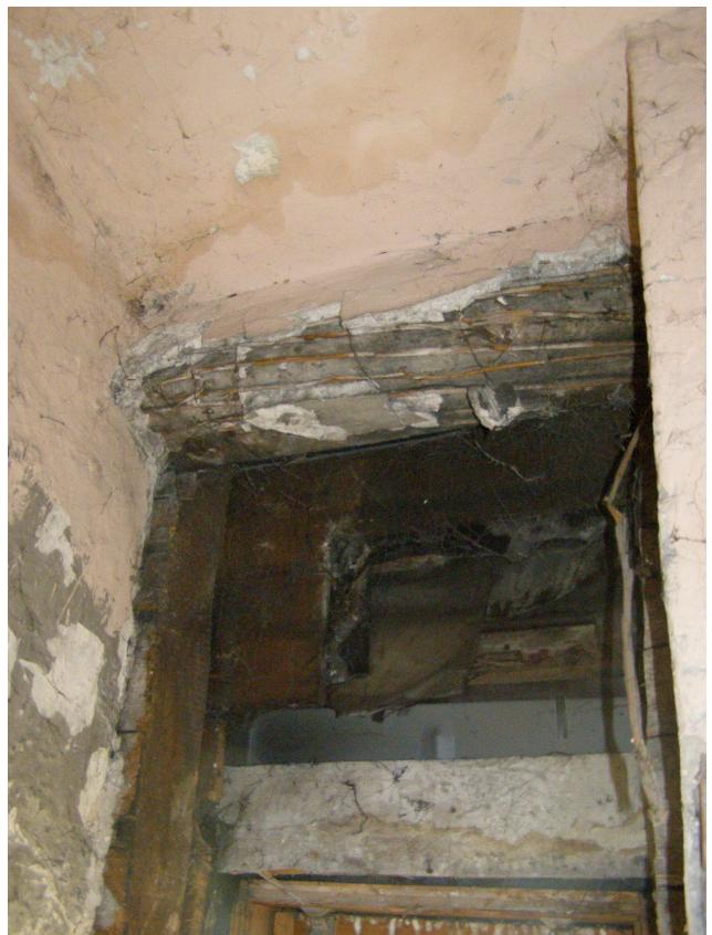
Foto. 29. Zawilgocenie stropu.
