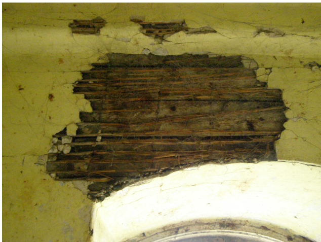
Foto. 17. Zawilgocenie deskowania.
