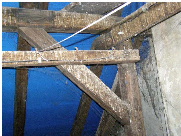
Foto. 6. Elementy konstrukcji więźby dachowej.
