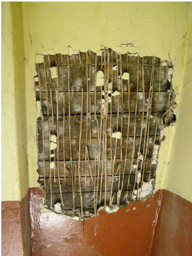
Foto. 42. Ubytki tynków.
