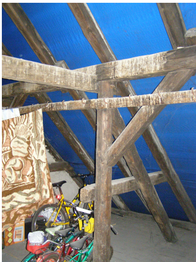
Foto. 4. Elementy konstrukcji więźby dachowej.
