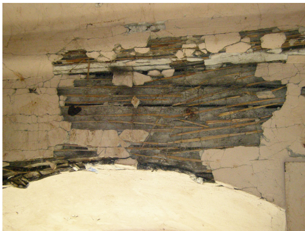
Foto. 43. Ubytki tynków.
