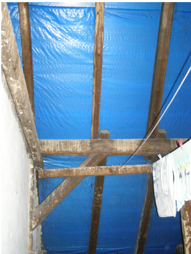
Foto. 7. Elementy konstrukcji więźby dachowej.
