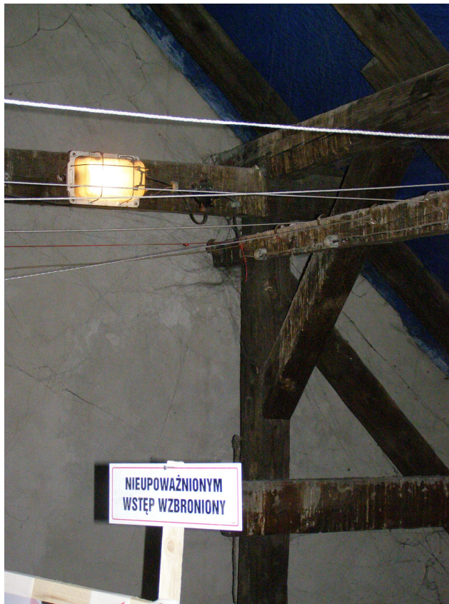
Foto. 5. Elementy konstrukcji więźby dachowej.
