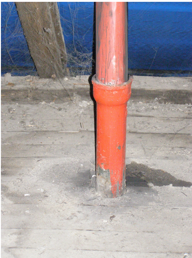
Foto. 28. Zawilgocenie stropu.
