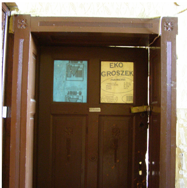
Foto. 37. Charakterystyczna stolarka drzwiowa.
